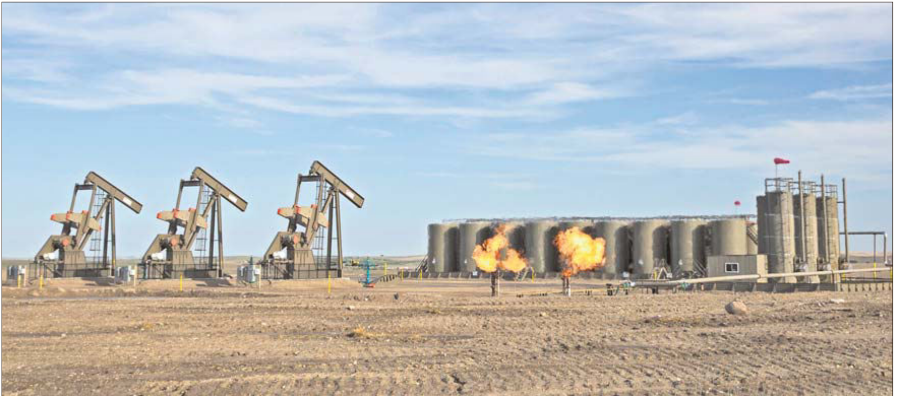
Watford City, North Dakota, USA: Erdgas wird beim Abpumpen von Öl abgefackelt, da keine Rohrleitungen gebaut wurden, um es in das System einzuspeisen.
